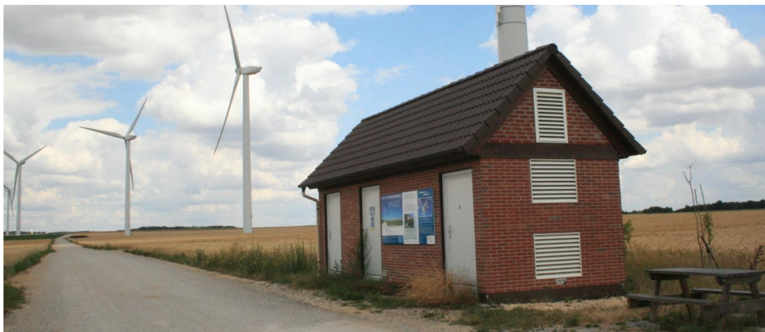
Illustration 2 : le poste de livraison « d'accueil » du parc de Chemin des Haguénets en bordure de la RD94
